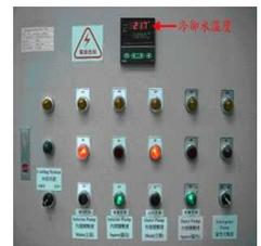
(圖五) 冷卻水控制器
